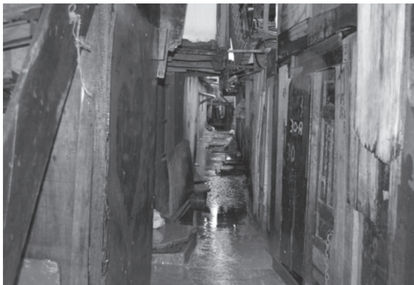
Favela da Linha antes de uma obra de saneamento realizada pela Companhia de Saneamento Básico do Estado de São Paulo (Sabesp).
